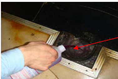
尿石除去洗剤を投入し除去します
